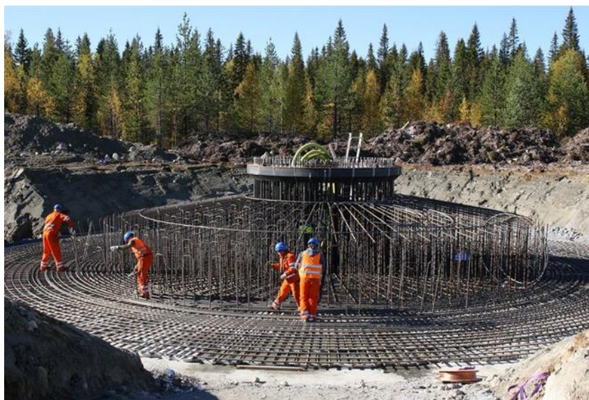
Fundament for vindturbin, Solberg vindkraftspark, Sverige (Foto: Fortum)
