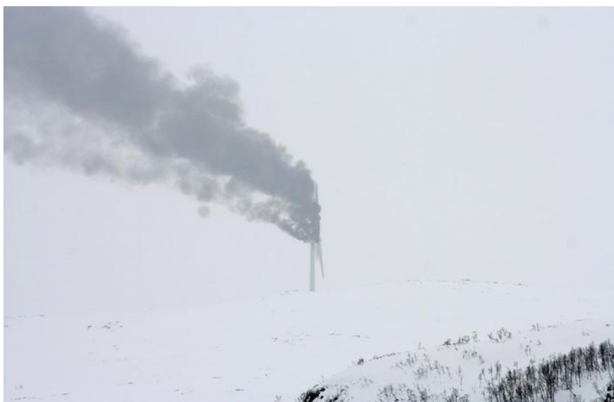
Testturbinen «Margrethe Kitti» i brann, 2010. (Foto: Geir Ytteraård)
