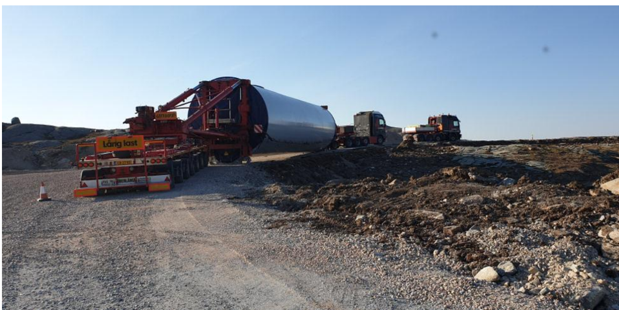
Del av vindturbintårn kjøres opp på Storheia for å monteres. (Foto: Arvid Jåma)
