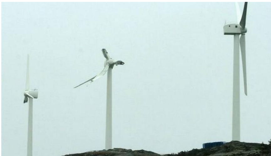
Havarerte vindturbiner, Hundhammerfjellet, reinbeitedistrikt 18, Voengelh-njaarke, 2008. (Foto: ???)
