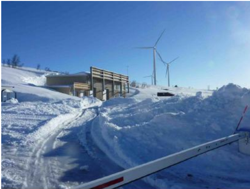
Nygårdsfjellet vindkraftvern – Driftsbygningen ligger like ved E10 med bom på anleggsvegen (Foto: Peer Gaup)
