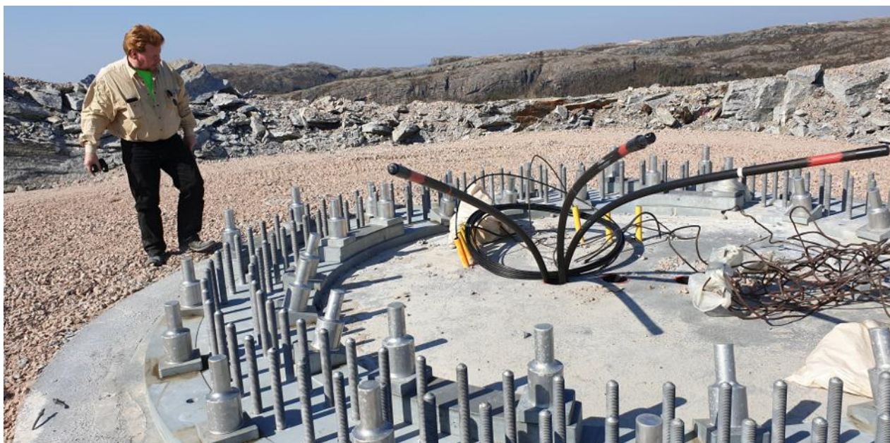
Fundament for vindturbintårn på Storheia. Foto: Arvid Jåma)
