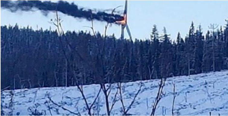
Burning wind turbine, Bösjövarden, Mora, Sverige, 23.02.2020.
